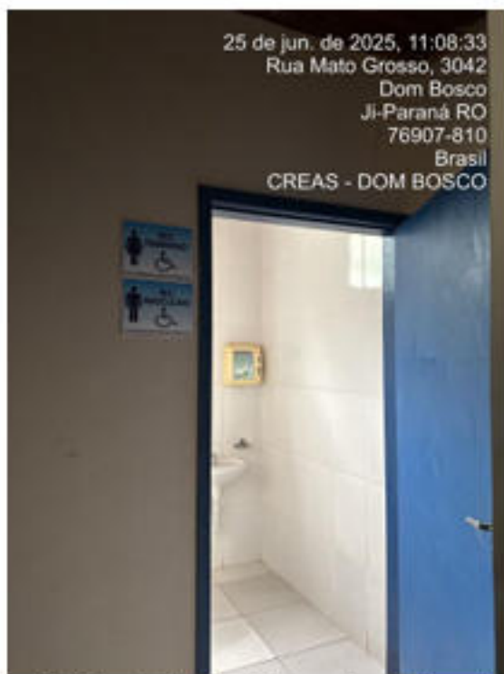
Figura 7: Banheiro de uso público sem barra e chapa de aço inox.
