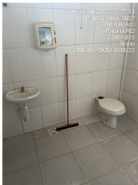
Figura 8: Banheiro sem barras de apoio.
